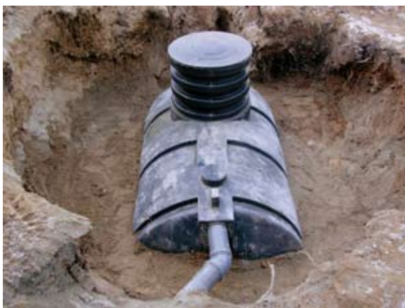
Zdjęcie 18. Montaż osadnika gnilnego
