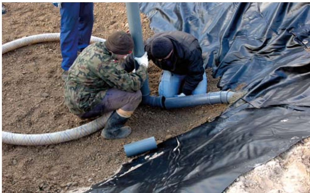
Zdjęcie 27. Wyprowadzenie drenażu zbierającego przez folię
