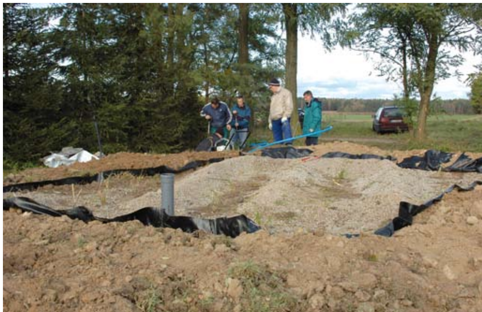
Zdjęcie 34. Drenaż rozsączający w obsypce żwirowej
