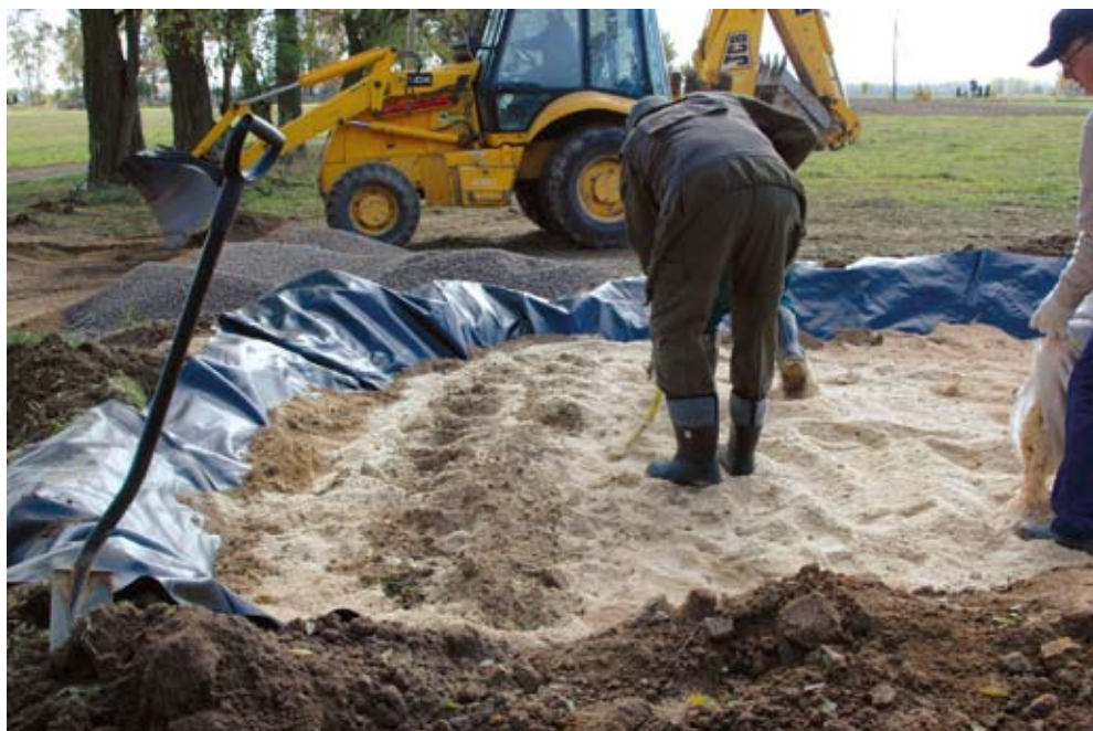
Zdjęcie 30. Usypanie warstwy trocin
