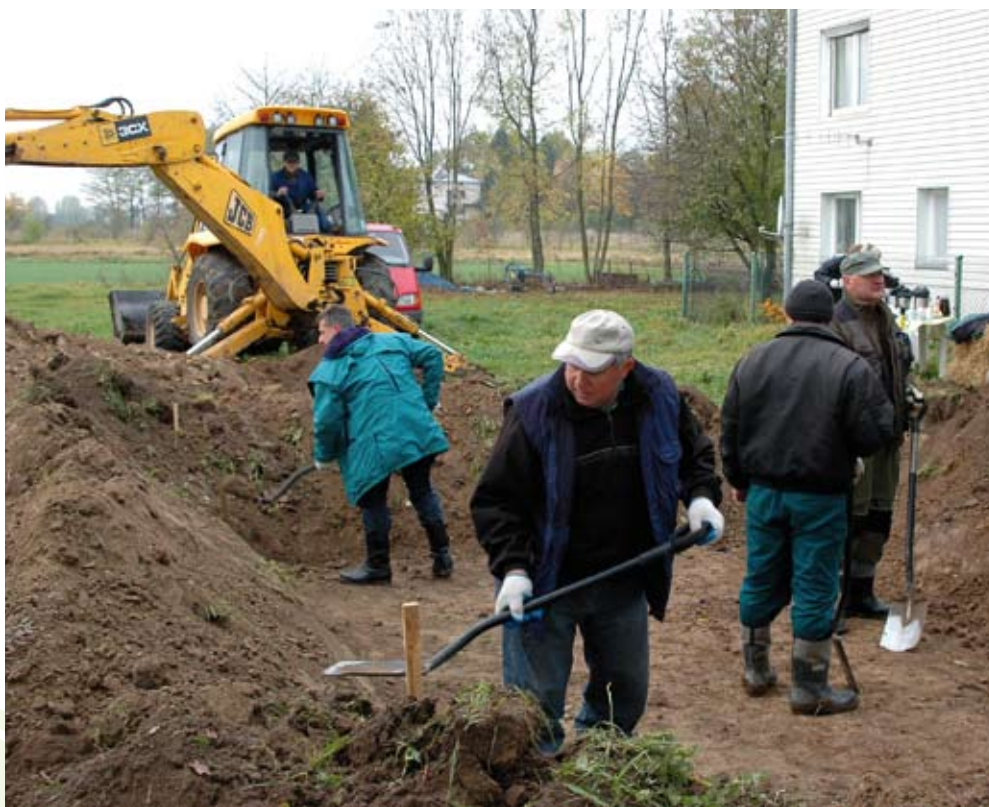
Zdjęcie 22. Wykop pod filtr gruntowo-roślinny
