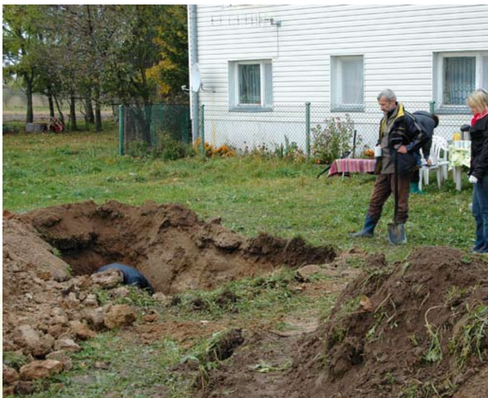
Zdjęcie 19. Wykop pod przepompownię
