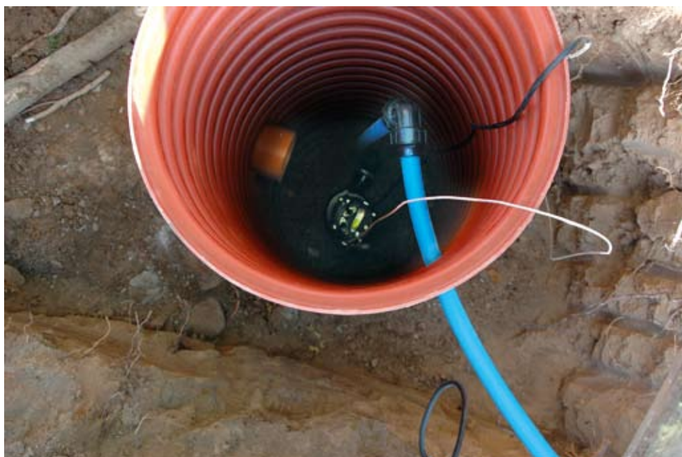
Zdjęcie 21. Przepompownia
