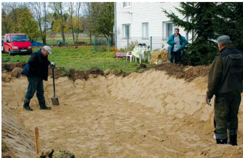
Zdjęcie 23. Wykonanie pierwszej warstwy filtra – piasku po folię.
