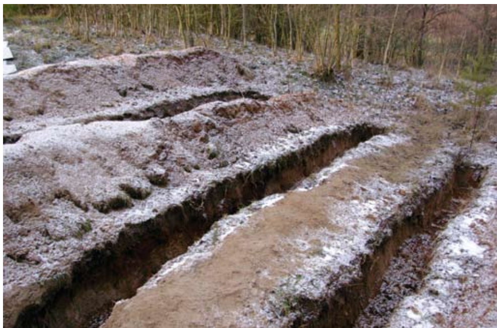
Zdjęcie 38. Wykopy pod drenaż rozsączający
