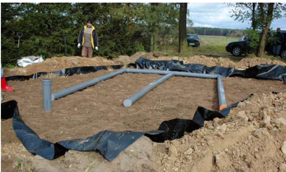
Zdjęcie 33. Układanie drenażu rozsączającego
