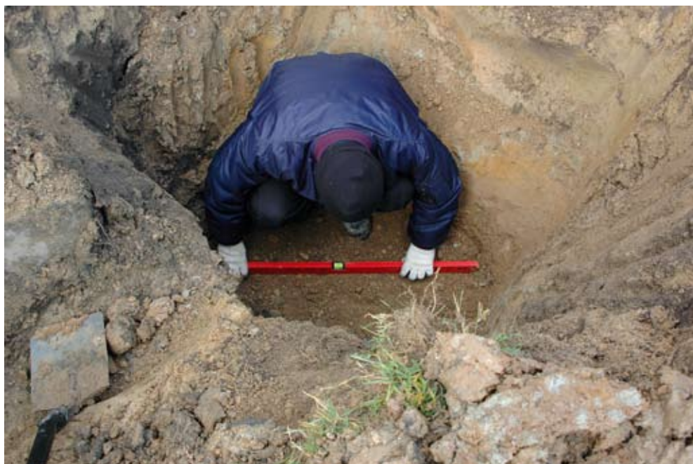
Zdjęcie 20. Poziomowanie dna wykopu pod przepompownię
