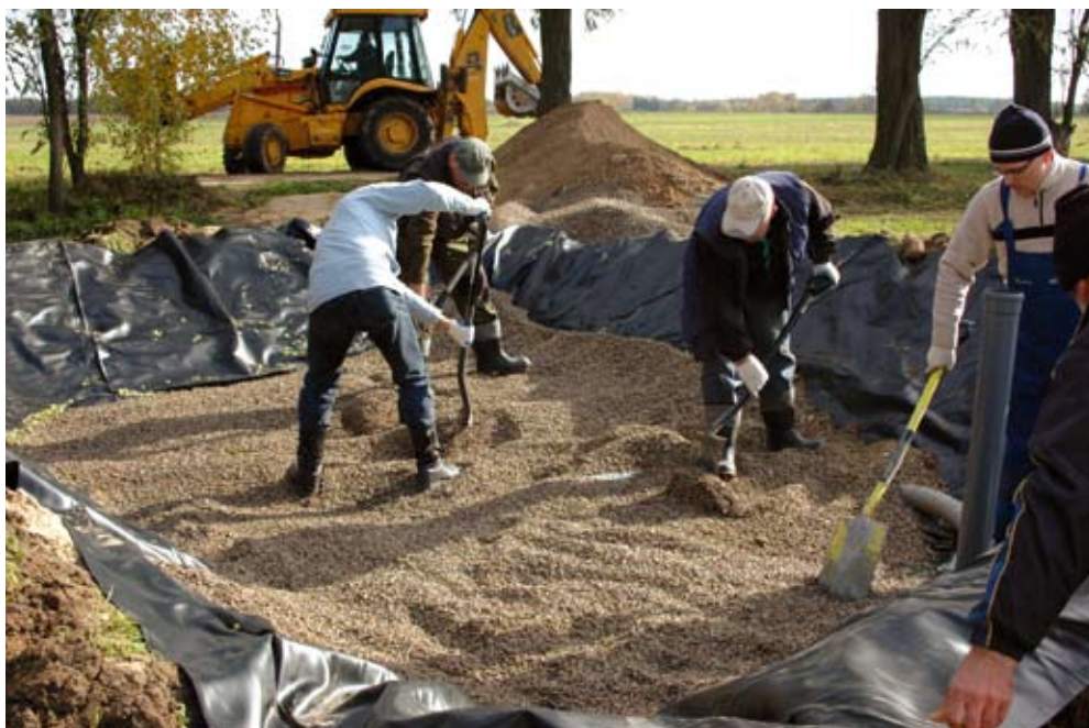
Zdjęcie 28. Obsypanie drenażu zbierającego kruszywem
